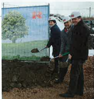
Erst wird geschaufelt, dann gebaut: Spatenstich für das Wohnbauprojekt der Gewerkschaft der Privatangestellten im 22. Bezirk.
